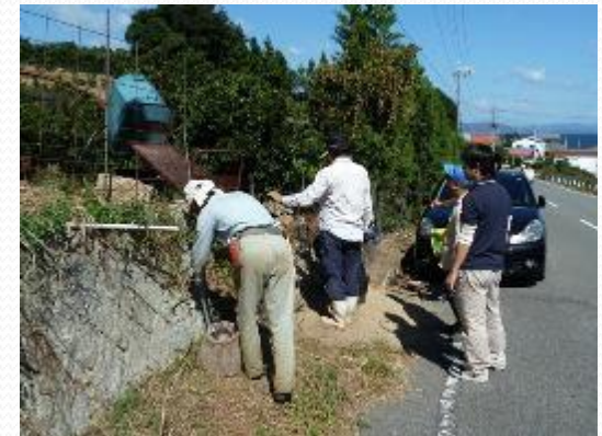
共同侵入防止策設置
