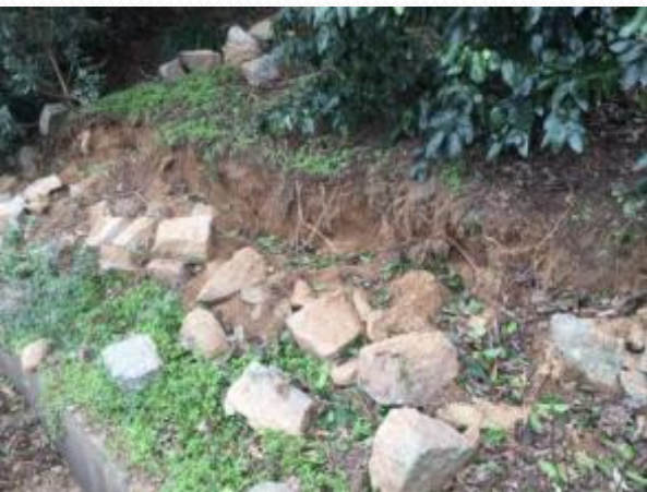
石垣を崩す被害
